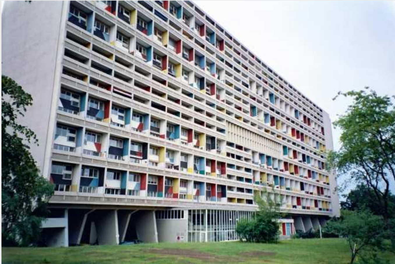
Unite de habitation, Marseille, Le Corbusier, 1952.
