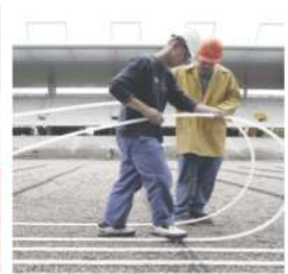
Грејање таваничног покрива
