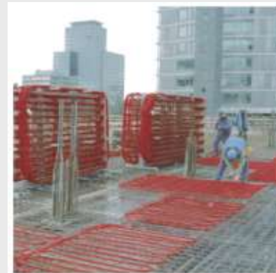
Припремање бетонског језгра
